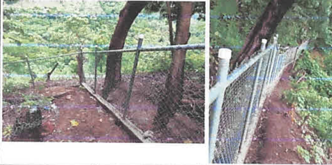
FOTO 1: INSTALACIÓN DE MALLA
