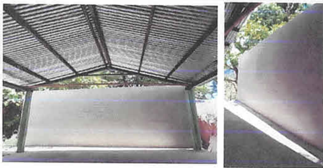
FOTO 3: LEVANTADO DE MURO + TALLADO EN PARTE POSTERIOR DE ESCENARIO
