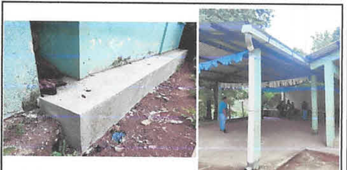
FOTO 6: BANQUETA DE CONCRETO MAS LEVANTADO DE BLOCK E INSTALACIÓN DE CANAL RECOLECTOR GALVANIZADO PARA AGUA PLUVIAL MAS BAJADA DE TUBO PVC DE 4"
