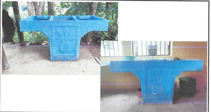
FOTO 4: SUMINISTRO E INSTALACIÓN DE 2 PILAS DE 2 LAVADEROS
