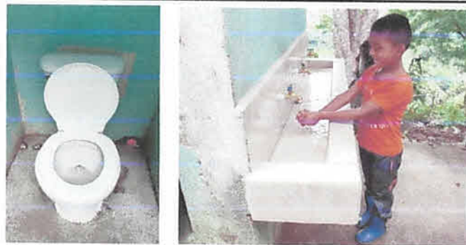
FOTO 5: INSTALACIÓN DE 2 INODOROS Y ELABORACIÓN DE LAVAMANOS FUNDIDO CON 3 CHORROS
